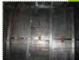
驚いた事に、開口部のガラスも鉛入りガラスがはめられ、コンセントボックスや、エアコンの室内機も同様に鉛のボードで覆われており、完全に他室へのX線漏れを防いでいます。出入口のドアは1m x 2mの大きさの物で何と75kg ~ 80kgもあるそうです。まるでシェルターですね。
