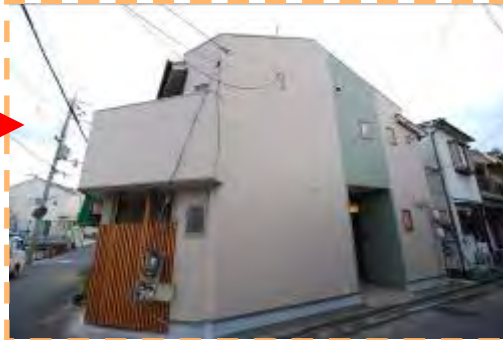
外壁は波板張りからサイディングに変更 アクセントカラーと木格子で新築並です
